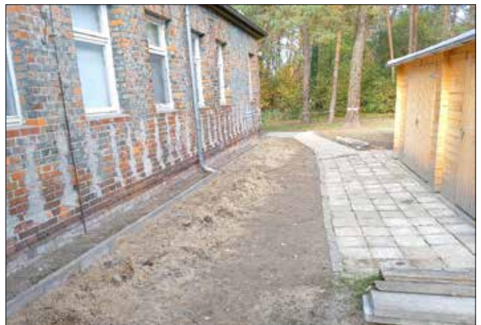
Abb. 6: Gestaltung des Umfeldes um den Material- und Geräteschuppen
