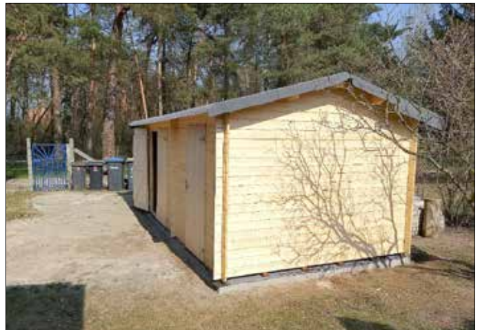
Abb. 5: Der Material- und Geräteschuppen ist fertiggestellt.
