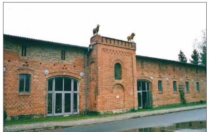
Schafstall Niebendorf 1845 starben 245 Tiere beim Einsturz des alten Gebäudes (Sturm)
