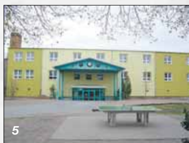
- Schule Haus III Malerarbeiten Anbau (5)
