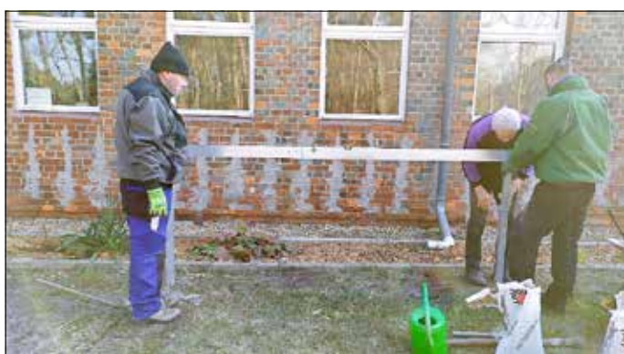
Setzen des Schutzzaunes für die Rosen aus Ravensbrück
